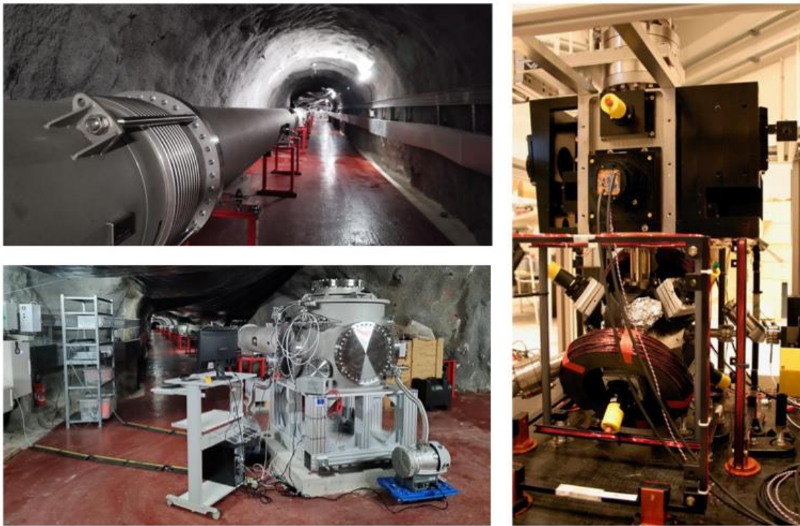
Gauche : antenne MIGA dans l'infrastructure souterraine du laboratoire LSBB. Droite : Source d'atomes froids de Rb de l'antenne
